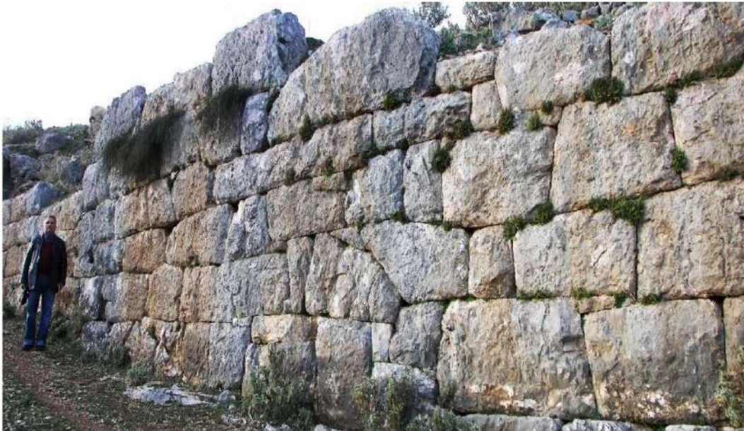
FIGURA 30 - KLOS. MURI RRETHUES I SHEK. V P. KR. FOTO N. CEKA.
